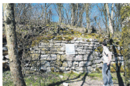
Burgruine Alt-Lägern: Die Burg auf dem Grat der Lägern westlich der Hochwacht wurde Mitte des 13. Jahrhunderts gebaut. Sie existierte nur rund 50 Jahre. Die Bewohner, die Ritter von der Lägern, verarmten und starben aus.
